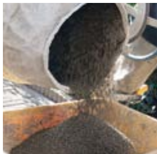
2. MIXEN BINDMIDDEL EN SPLIT IN DE BETONMOLEN
